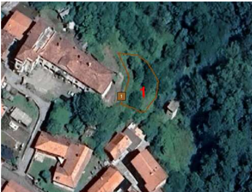
1 - Movimento franoso in prossimità di Via Roma.
