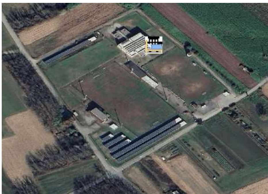
Palazzetto dello Sport Pala Ponti sito in via Dieci Martiri n.51.
