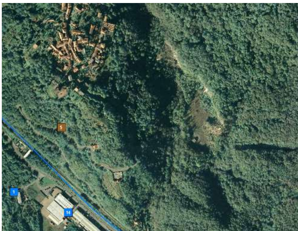
5 - Possibili frane sulla Strada per Ara.
