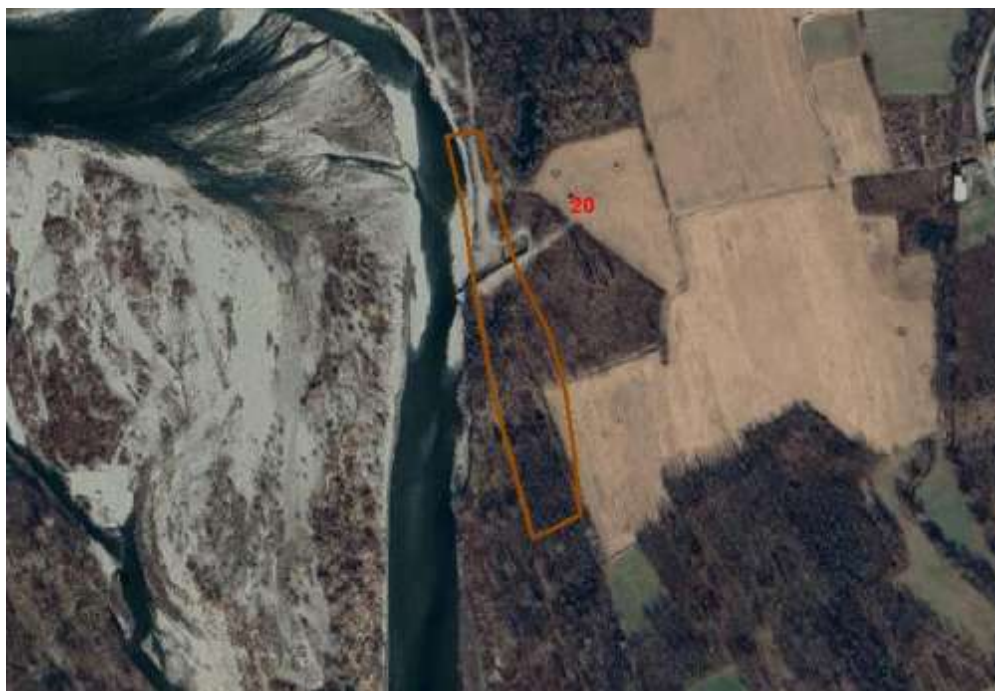
1 - Erosione Argine località Via Cattaneo.
