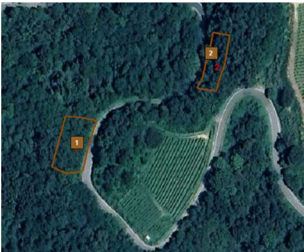
1 e 2 - Movimento franoso sulla strada Provinciale 32.
